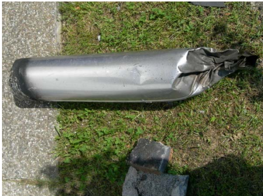
Bild 3 Blitzwirkungen an einem Edelstahlfangsystem. Das rechte Ende ist durch äußere Druckeinwirkung in Folge der Blitzeinwirkung, wie im Bild ersichtlich, verformt worden. Quelle: OÖ Blitzschutzgesellschaft
